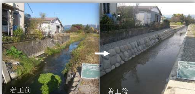
玉石を用い、多孔質な護岸に整備し、生物の生息に適した構造としました。
