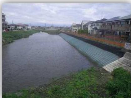
小出川での改修の様子
