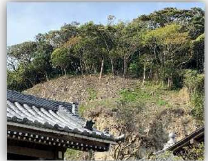
景観等に配慮した防災工事の実施 (鎌倉市大町)
