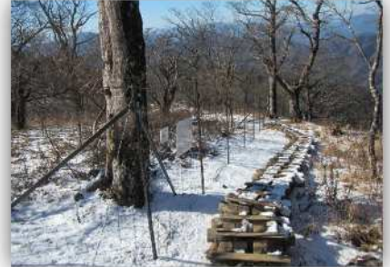
植生保護柵の設置状況
