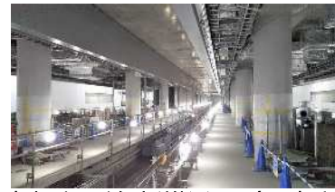
東部方面線 新横浜駅（工事中）
