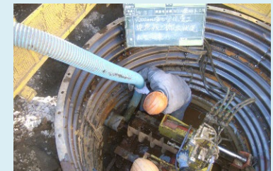
⑧生活排水処理施設の整備促進(下水道・浄化槽) 道路を開削せず、トンネル状に掘削した穴に管を通す工法により下水道管を敷設した。(相模原市緑区)
