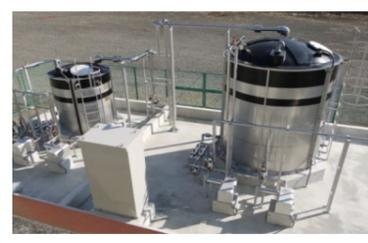
③相模川水系上流域対策 山梨県内の下水処理場に設置したリンを取り除くための設備を稼動した。(山梨県桂川清流センター)
