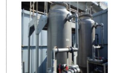
⑦地下水保全対策 有機塩素系化学物質で汚染された地下水を施設の装置に通すことにより水質浄化を図った。(秦野市)
