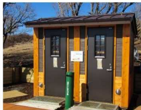
環境配慮型トイレ（木ノ又小屋）
