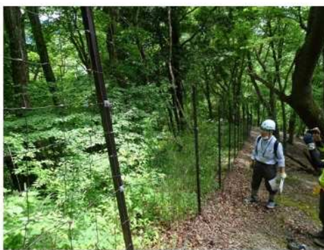
植生保護柵点検（ヌタノ沢）
