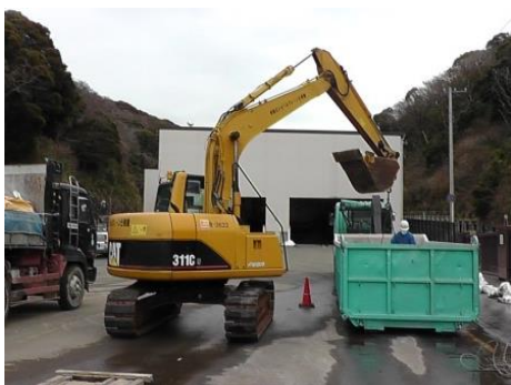
写真7 (吊り作業場所)
