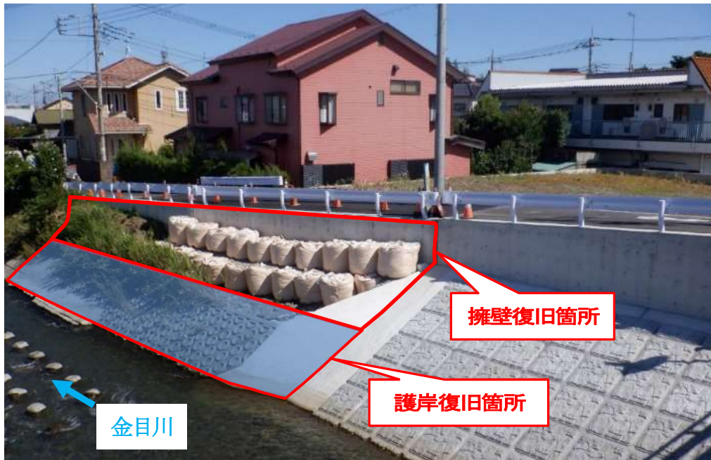
工事再開箇所(市道)付近の写真(7月撮影)
