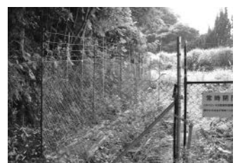
防護柵設置状況
