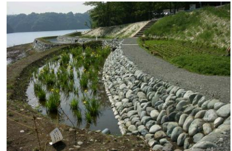
三井地区植物浄化施設
