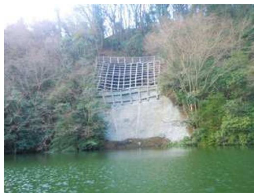
(津久井湖崩落防止工事)
