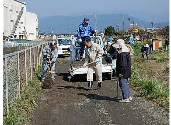
地域ぐるみで実施する農道の補修作業 (多面的機能支払事業)
