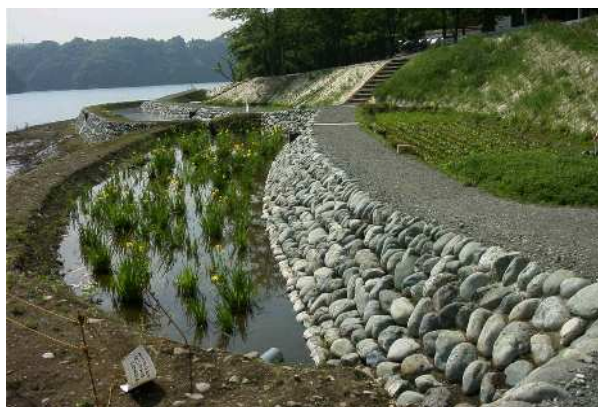
(三井地区植物浄化施設)
