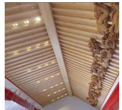
内装の木質化 (小田急線片瀬江ノ島駅)
