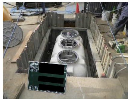
(一般家庭への浄化槽設置(相模原市))
