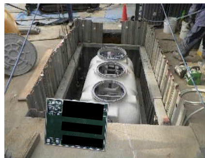
(一般家庭への浄化槽設置(相模原市))
