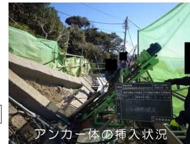
グラウンドアンカーの施工状況
