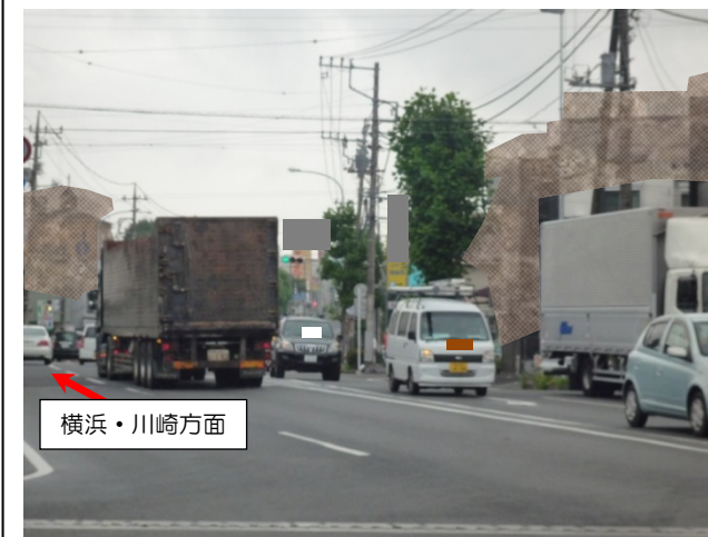
横浜市側 4車線整備済状況
