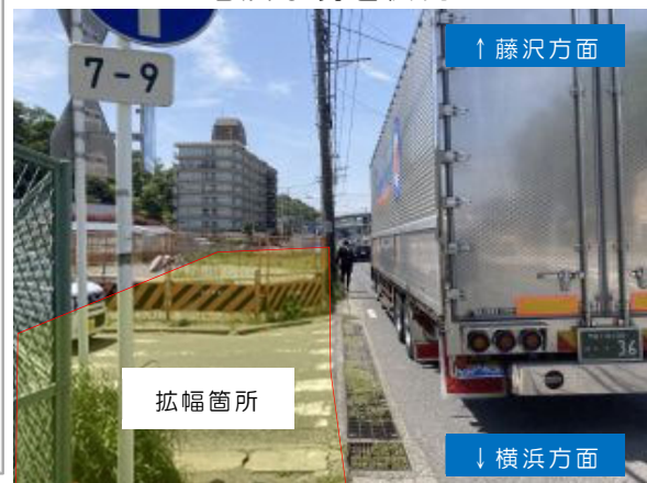
危険な現道状況
