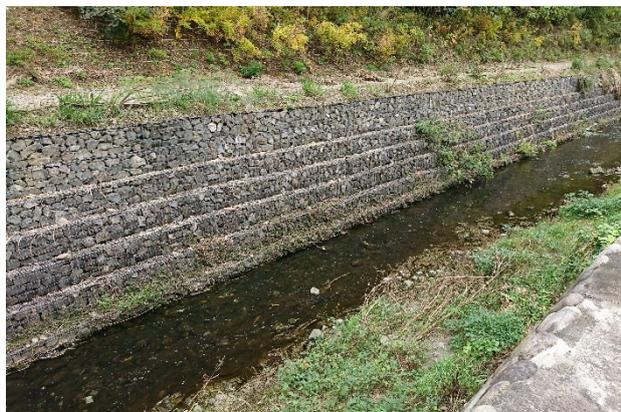
護岸に多孔質材を使用<sup>注</sup>
