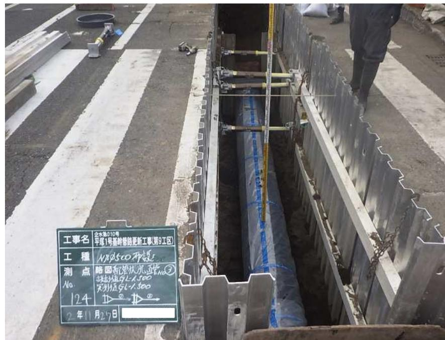
平塚1号基幹管路更新工事 耐震継手管理設工の様子
