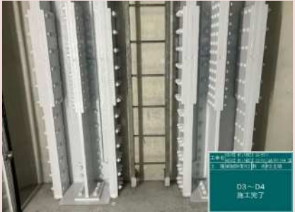
補強後の状況(P2主塔内部)
