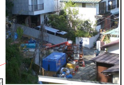
区域外に資材搬入拠点を設置
