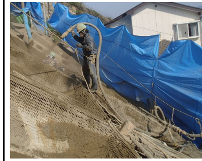
材料の長距離輸送が可能な工法を採用
