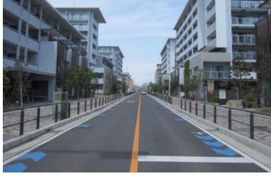
無電柱化（道路整備）
