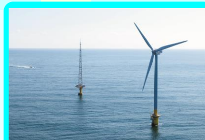
銚子沖洋上風力発電所
