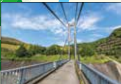
4 松ヶ山橋 ダムを正面に見ることができます。
