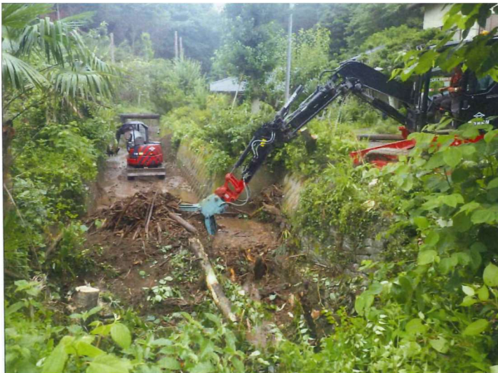
機械と人力で流木の撤去作業を行っています
