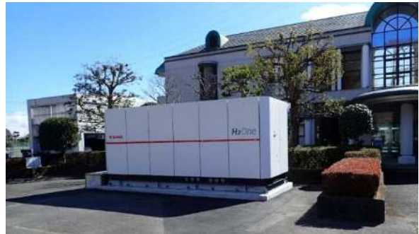
完成した「水素エネルギー供給設備」
