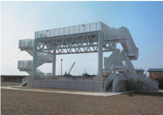
津波避難タワー
