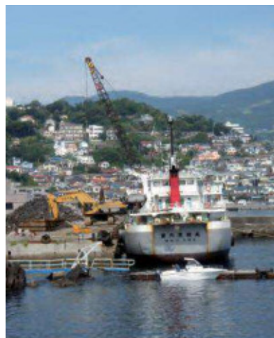
石材の積込み(石材専用物揚場)
