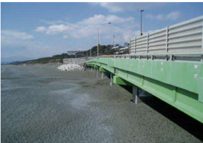
耐震化した臨港橋梁（西湘バイパス 大磯港 IC オンランプ）
