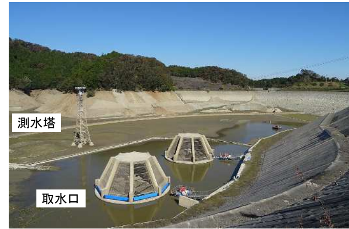
城山発電所取水口(上池干池時)
