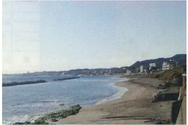
野比海岸（侵食対策の離岸堤）
