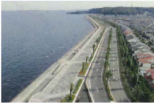
馬堀海岸（高潮対策護岸）
