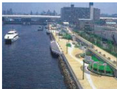
千葉港海岸(船橋地区)
