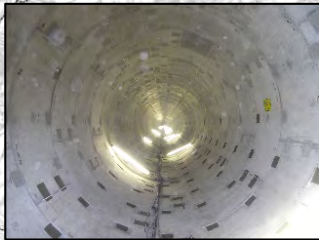
【横浜市】大岡川右岸雨水幹線
