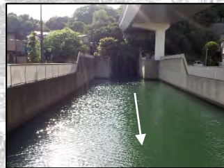
【神奈川県】大岡川分水路出口部
