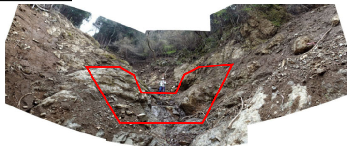
谷止工施工予定地
