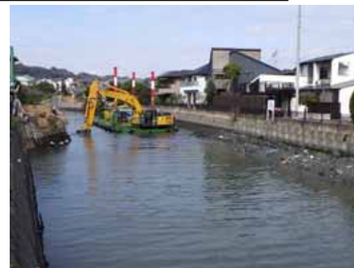
施工状況写真（航路掘削）
