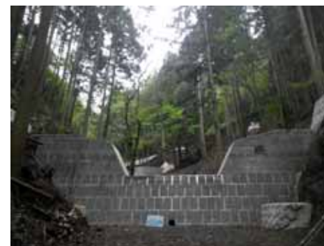
谷止工施工済み箇所
