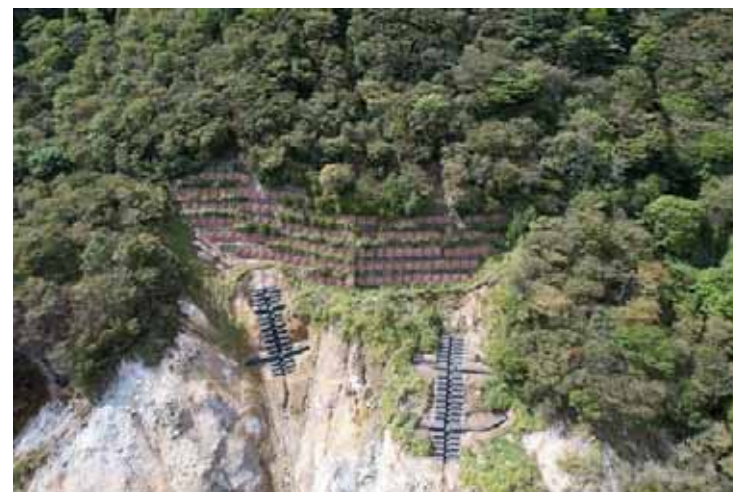
土留工、水路工設置状況
