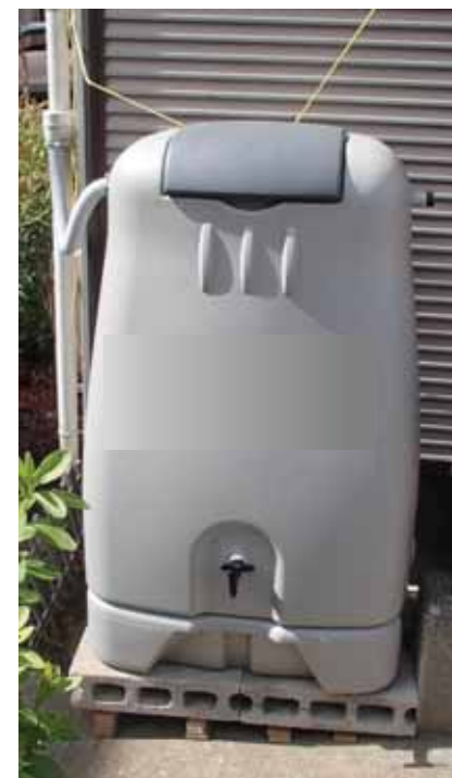
雨水貯留槽設置例
