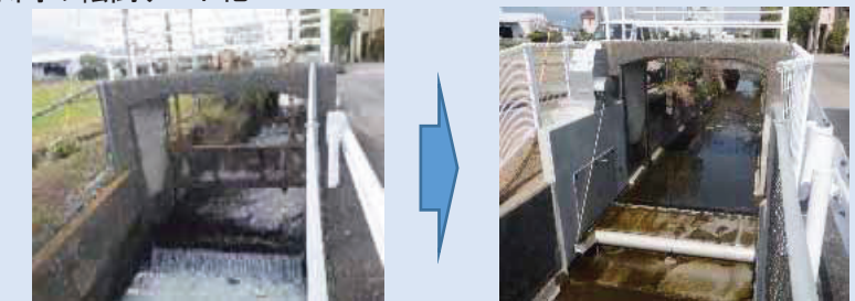
水門の転倒ゲート化
