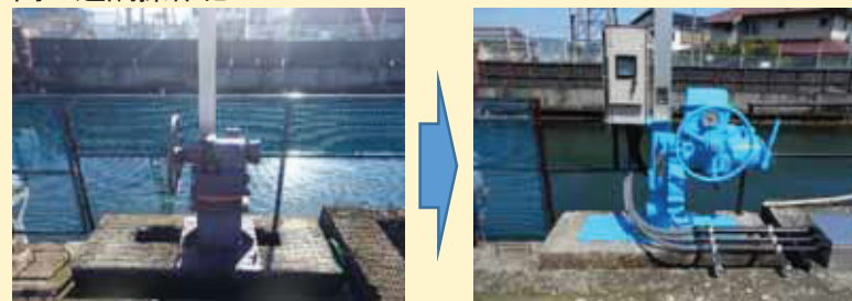
水門の転倒ゲート化
