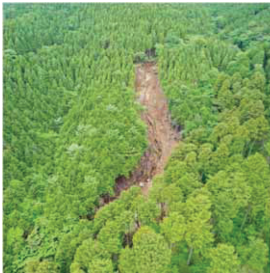
山腹崩壊状況
