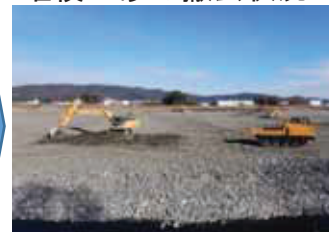
堆積土砂の撤去状況
