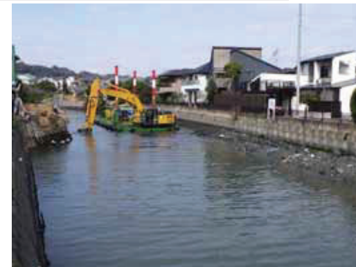
施工状況写真（航路掘削）
