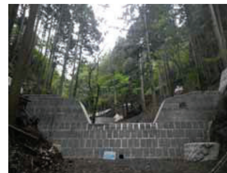
谷止工施工済み箇所
