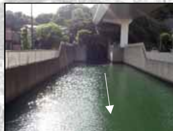
【神奈川県】大岡川分水路出口部
