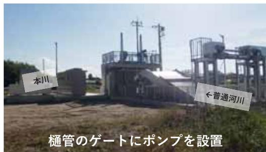
樋管のゲートにポンプを設置
