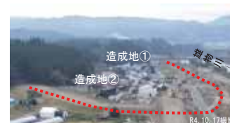
移転家屋の建設が進む状況
