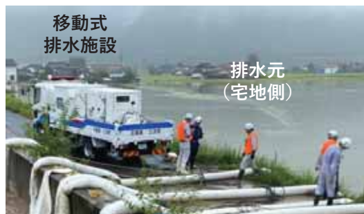
樋管のゲートにポンプを設置
