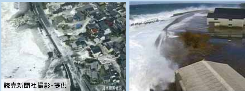
高波による越波・浸水状況
