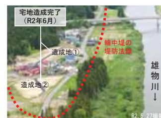
移転先宅地造成完了状況
