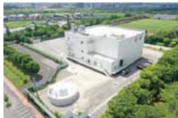
雨水ポンプ場
