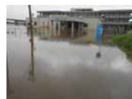
浸水時の状況 (喜多方市提供)
