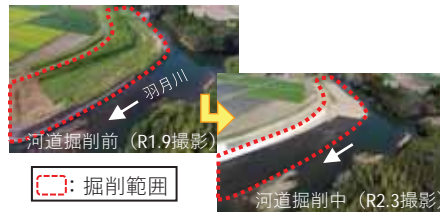
河道掘削(鹿児島県内川水系羽月川)
