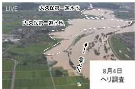
【遊水地への湛水状況(令和4年8月4日)】
