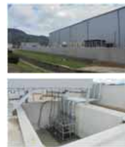
工場での浸水対策例 （株式会社佐賀鉄工所HPより）
