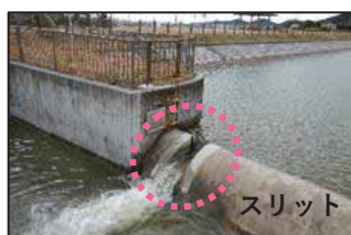
▲スリットの設置状況
