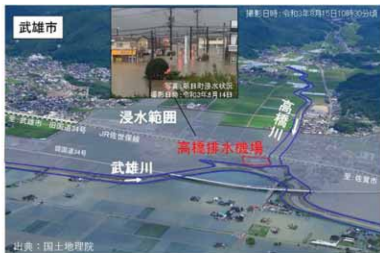
令和3年8月の大雨による武雄市(佐賀県)の内水被害
