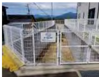
開発等による雨水流出増を抑える流出抑制対策のルール化
