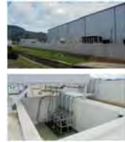
工場での浸水対策例 （株式会社佐賀鉄工所HPより）
