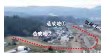
移転家屋の建設が進む状況
