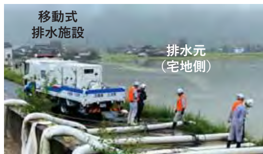
普通河川の管理者による排水状況（三次市） ※移動式排水施設は市が管理
