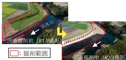
河道掘削(鹿児島県内川水系羽月川)
