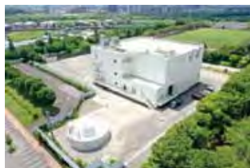
雨水ポンプ場
