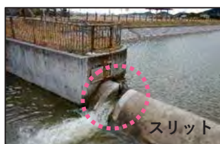
▲スリットの設置状況
