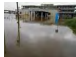
浸水時の状況 (喜多方市提供)
