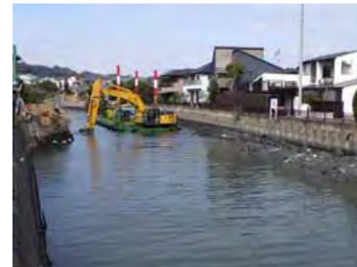
施工状況写真（航路掘削）
