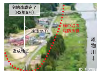
移転先宅地造成完了状況
