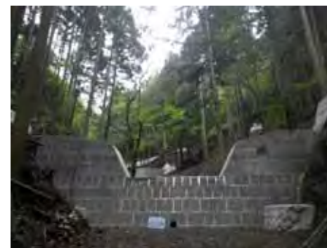
谷止工施工済み箇所
