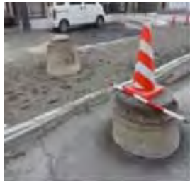
液状化被害写真（マンホール浮上） 出典：下水道管路施設における耐震化技術の有効性 国土交通省資料
