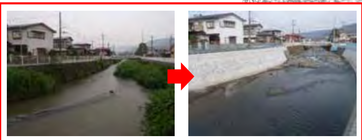
護岸整備等（天神橋～関口橋）
