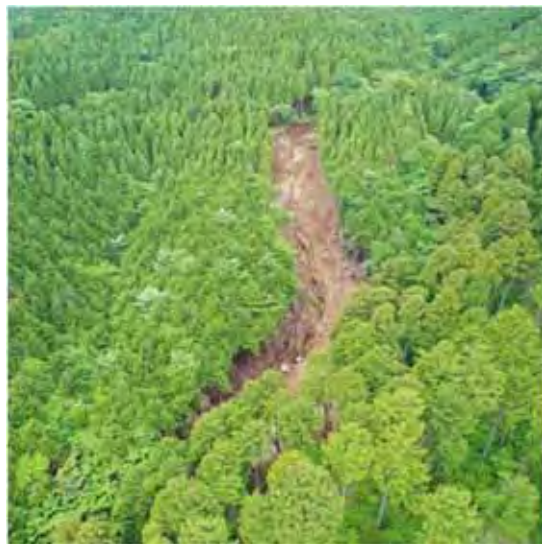
山腹崩壊状況
