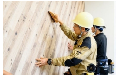
壁装実習 (壁装・床施工コース)
