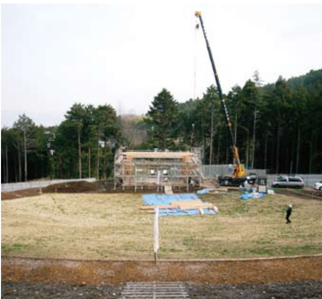
お野立所の建築工事着工
