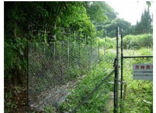
防護柵設置状況
