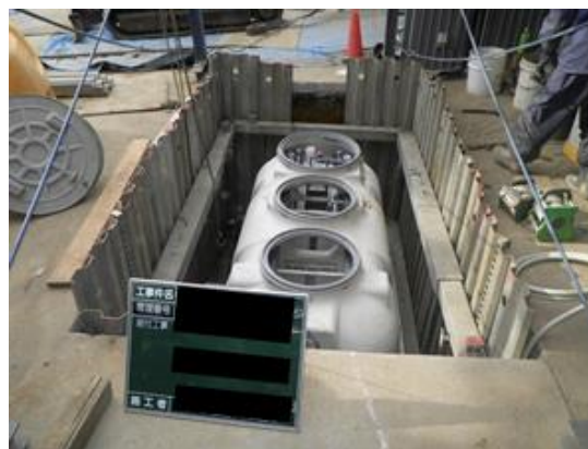
一般家庭への浄化槽設置(相模原市)
