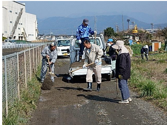
地域ぐるみで実施する農道の補修作業 (多面的機能支払事業 小田原市)
