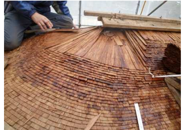
写真5 兜門の伝統的技法による檜皮葺替え
