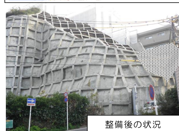
写真① 急傾斜地崩壊防止施設（法枠工）の整備例
