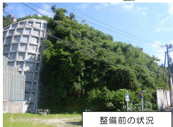
写真① 急傾斜地崩壊防止施設（法枠工）の整備例
