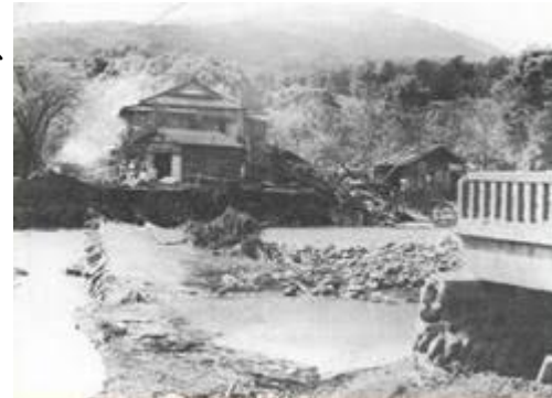
アイオン台風による被災状況(山北町)
