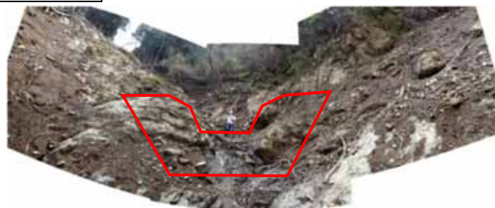
谷止工施工予定地
