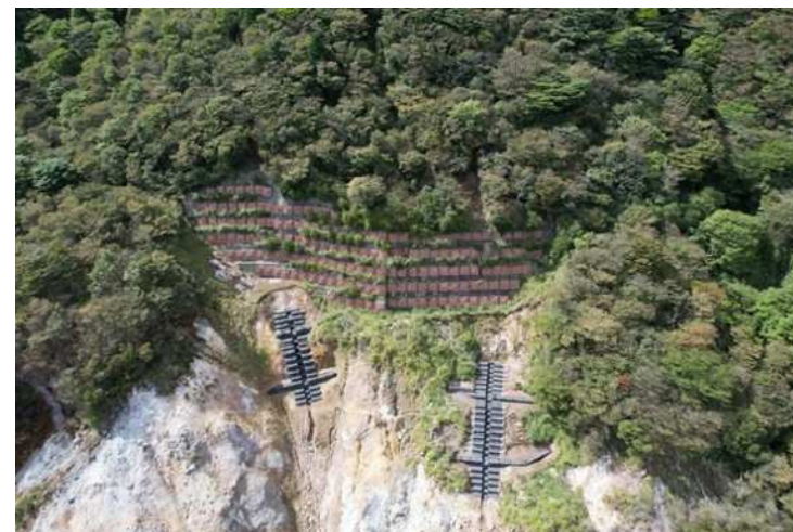
土留工、水路工設置状況
