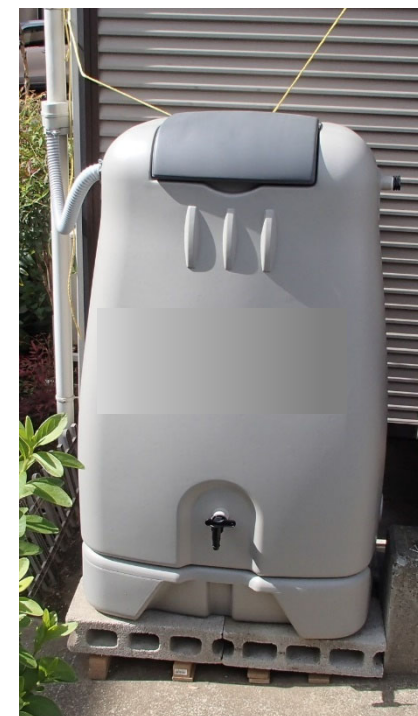
雨水貯留槽設置例
