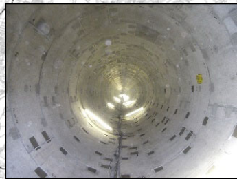
【横浜市】大岡川右岸雨水幹線
