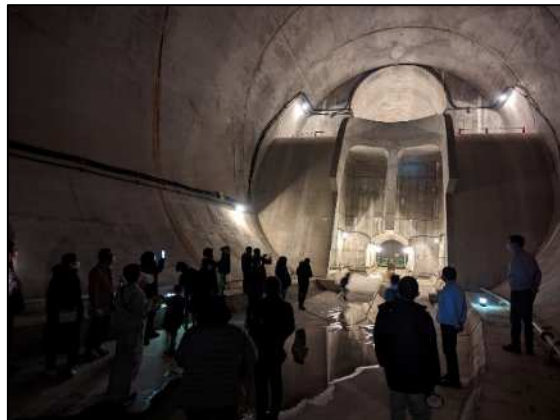
地下調節池内部②
