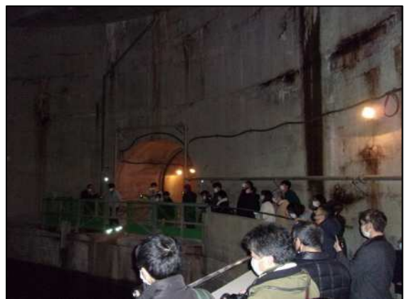
地下調節池内部①
