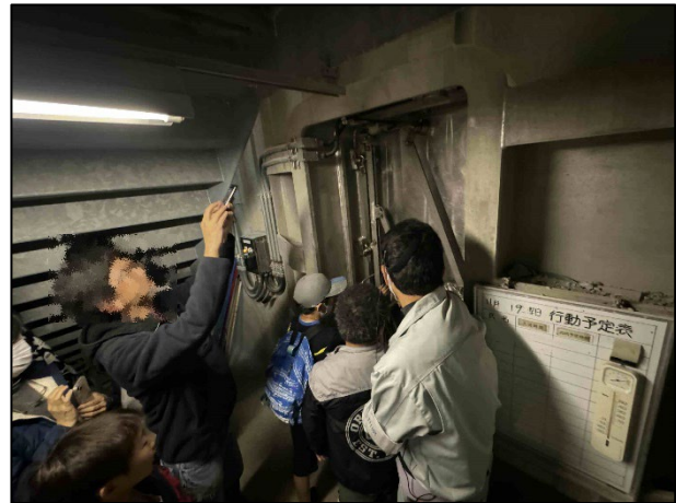
地下調節池内部①
