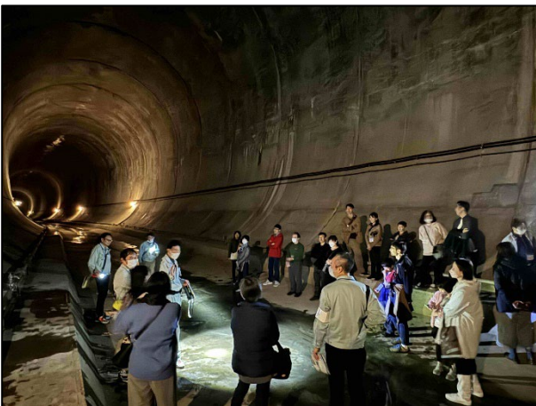
地下調節池内部④
