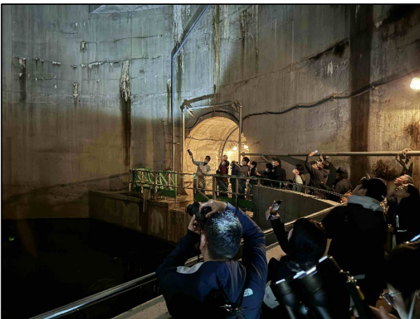
地下調節池内部②
